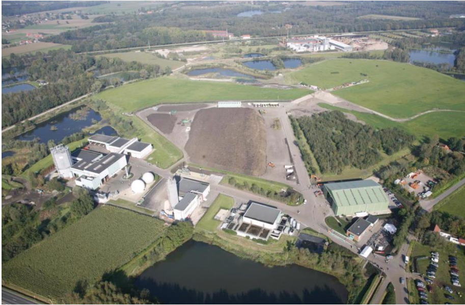
Figuur 36 Overzicht afvalverwerkingsite Noord van Igean te Brecht (Sint-Lenaarts) (bron: jaarverslag 2012 Igean: milieu- en veiligheid)
